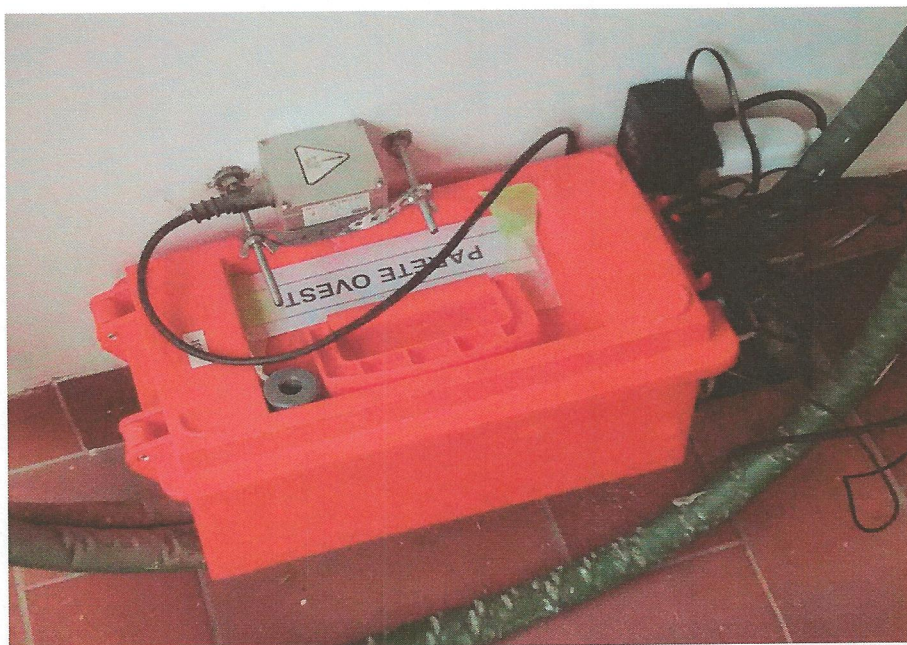
Installazione del trasduttore di velocità triassiale.
